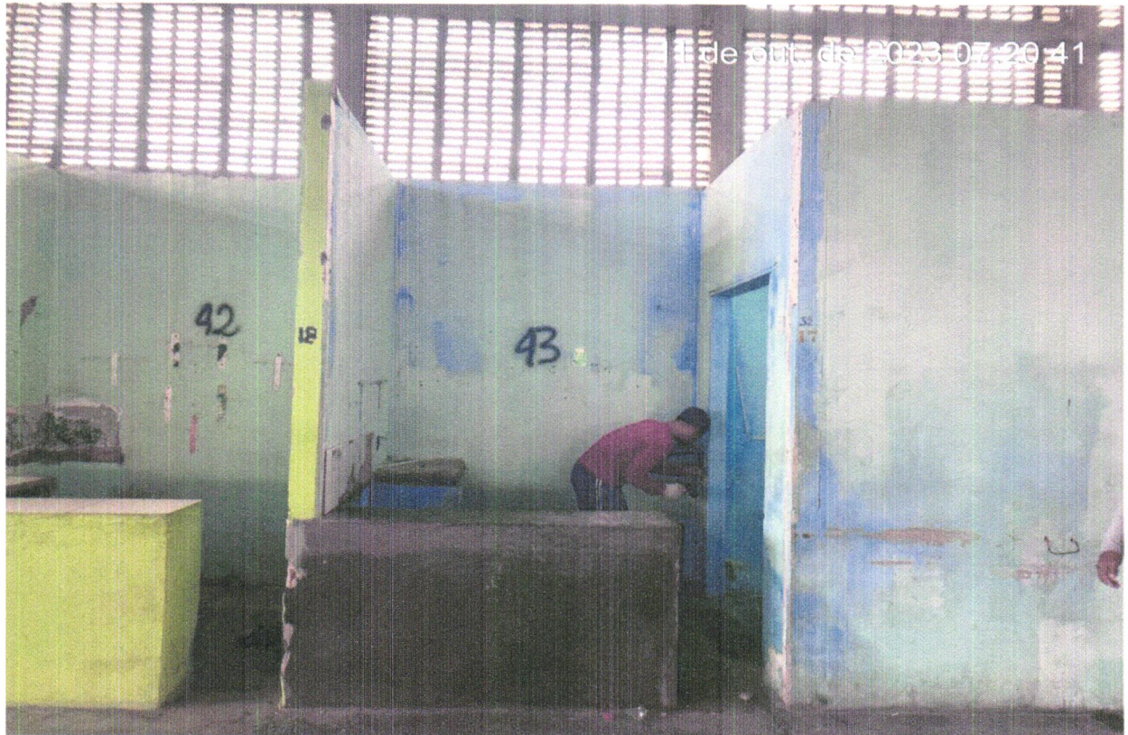
FOTO 32 - REMOÇÃO DE PORTAS, DE FORMA MANUAL, SEM REAPROVEITAMENTO.
