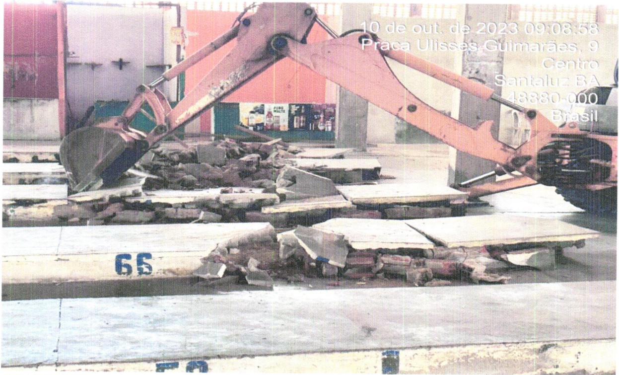
FOTO 22 - DEMOLIÇÃO MANUAL DE PISO CIMENTADO SOBRE LASTRO DE CONCRETO - REV 01
