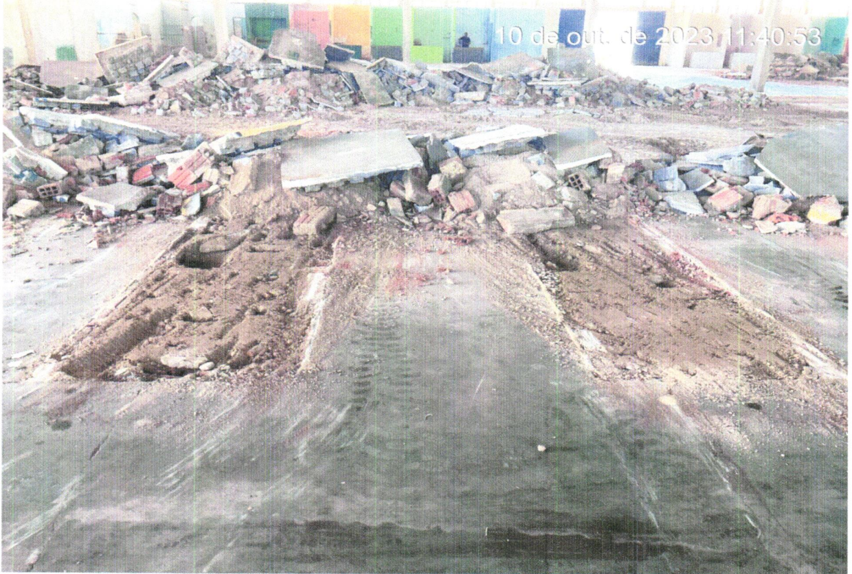
FOTO 24 - DEMOLIÇÃO MANUAL DE PISO CIMENTADO SOBRE LASTRO DE CONCRETO - REV 01
