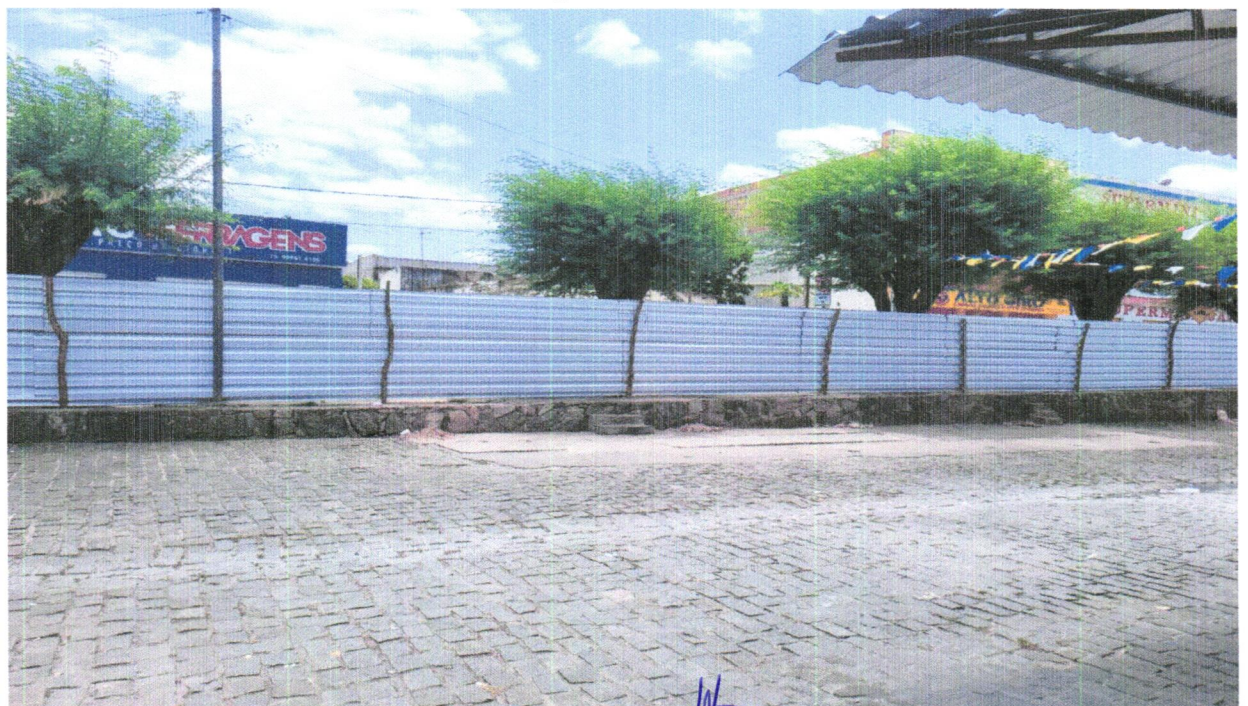
FOTO 08 - TAPUME COM TELHA METÁLICA. AF_05/2018
