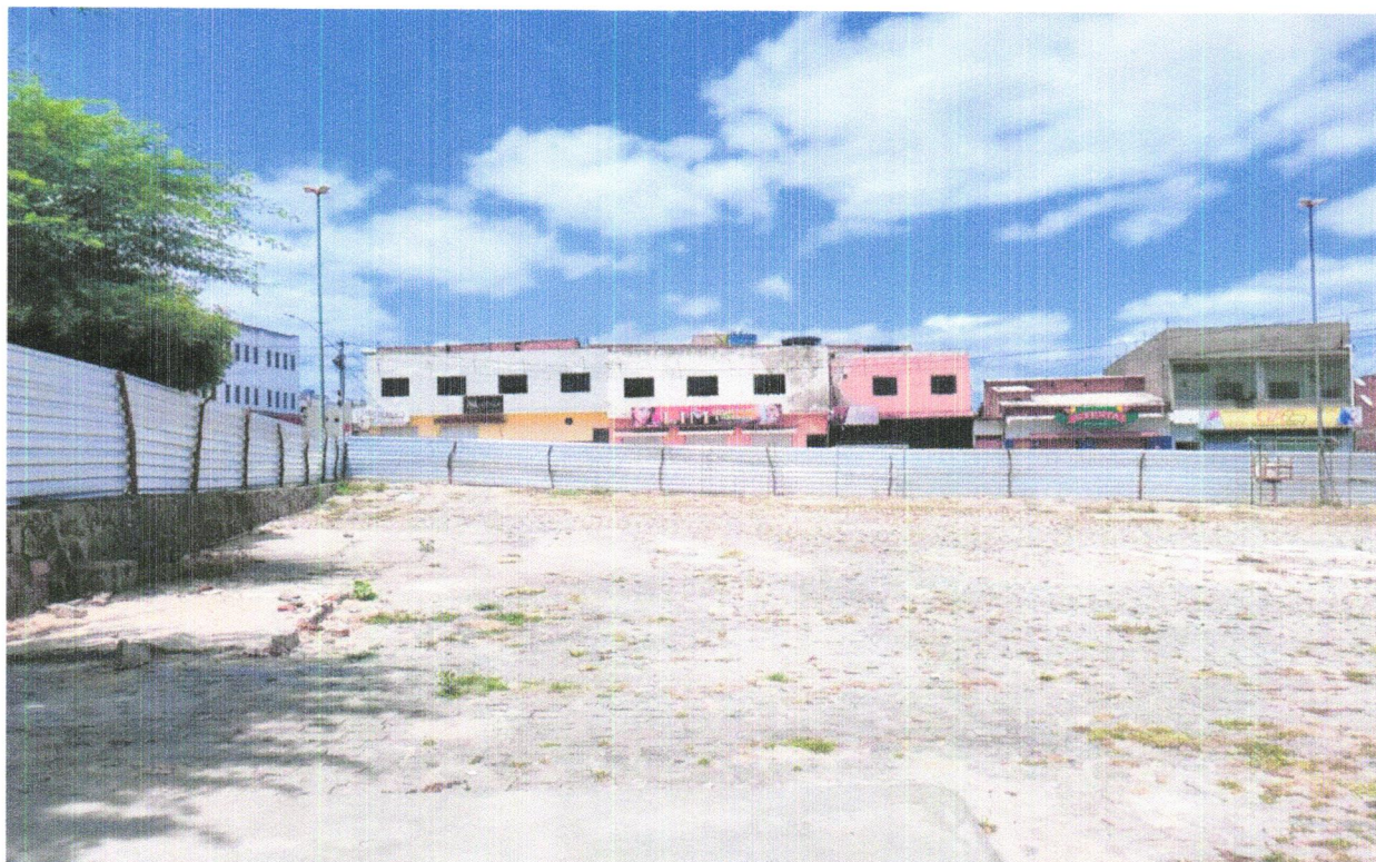
FOTO 12 - TAPUME COM TELHA METÁLICA. AF_05/2018
