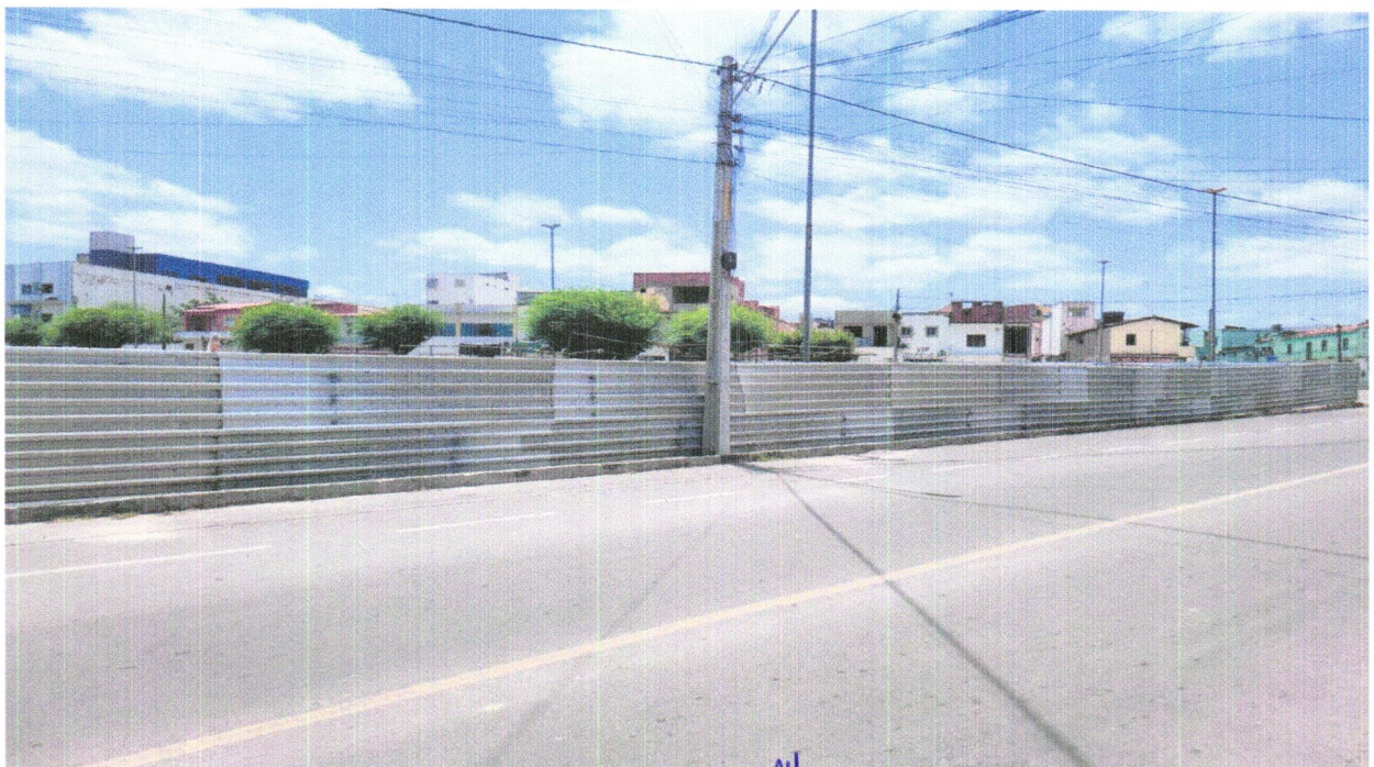
FOTO 10 - TAPUME COM TELHA METÁLICA. AF_05/2018
