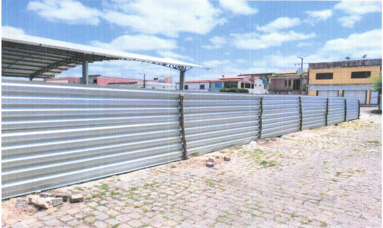
FOTO 08 - TAPUME COM TELHA METÁLICA. AF_05/2018
