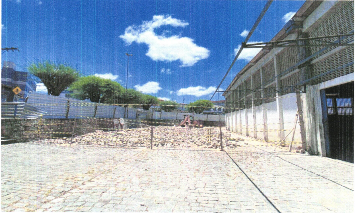
FOTO 16 - DEMOLIÇÃO DE PAVIMENTAÇÃO EM PARALELEPÍPEDO SEM REAPROVEITAMENTO
