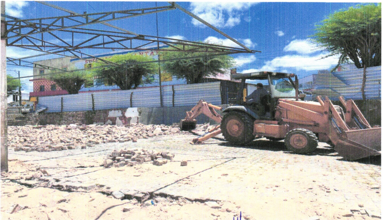
FOTO 16 - DEMOLIÇÃO DE PAVIMENTAÇÃO EM PARALELEPÍPEDO SEM REAPROVEITAMENTO
