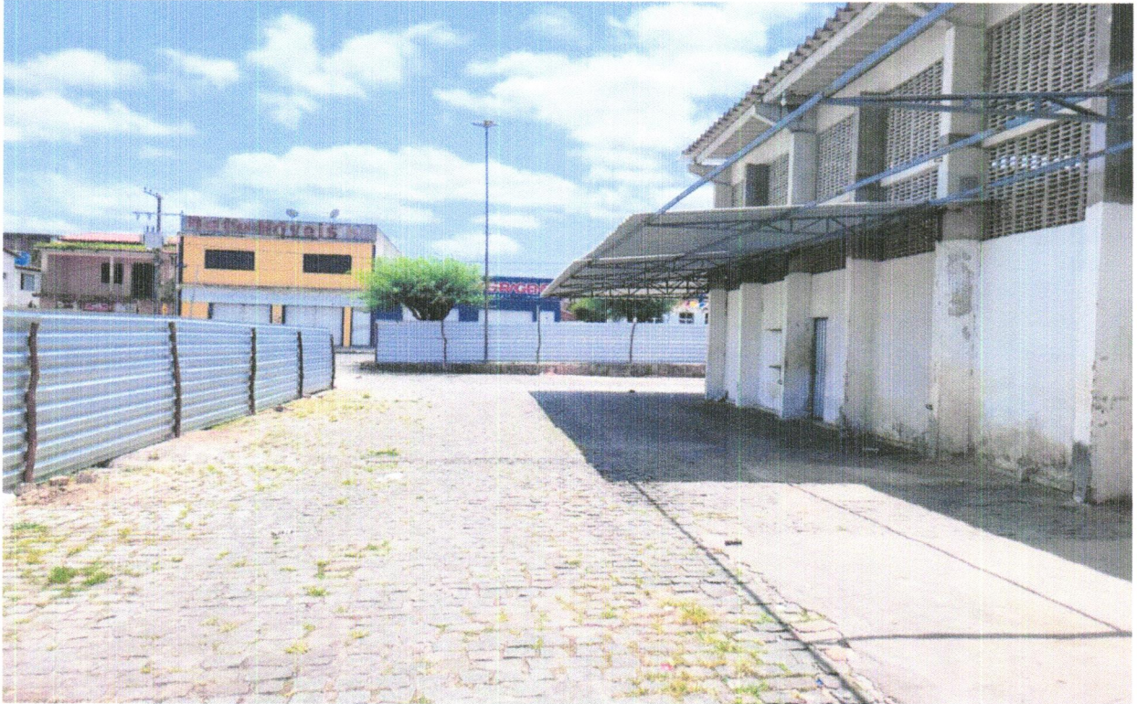
FOTO 06 - TAPUME COM TELHA METÁLICA. AF_05/2018
