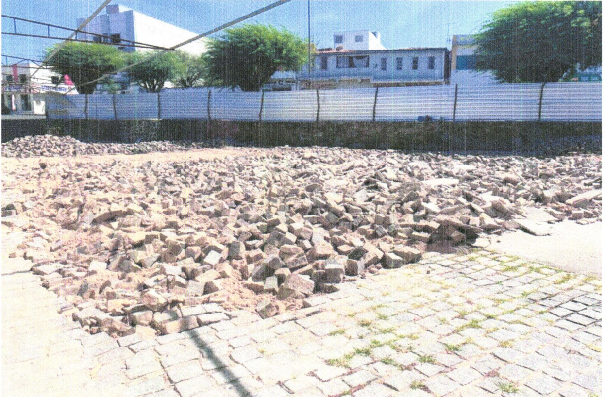
FOTO 18 - DEMOLIÇÃO DE PAVIMENTAÇÃO EM PARALELEPÍPEDO SEM REAPROVEITAMENTO
