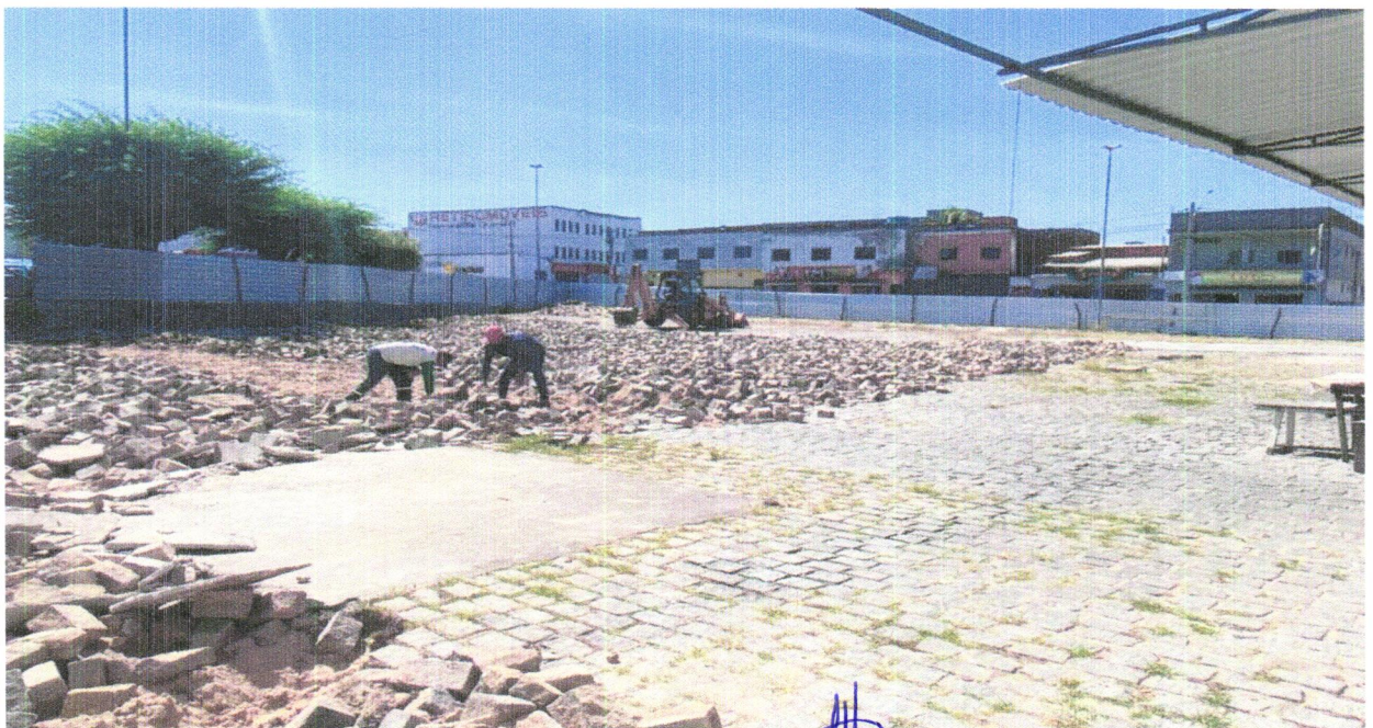
FOTO 18 - DEMOLIÇÃO DE PAVIMENTAÇÃO EM PARALELEPÍPEDO SEM REAPROVEITAMENTO
