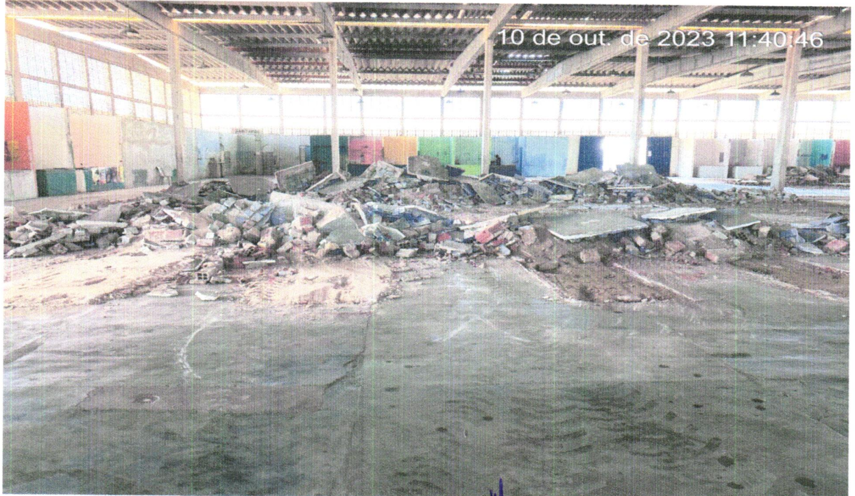
FOTO 22 - DEMOLIÇÃO MANUAL DE PISO CIMENTADO SOBRE LASTRO DE CONCRETO - REV 01
