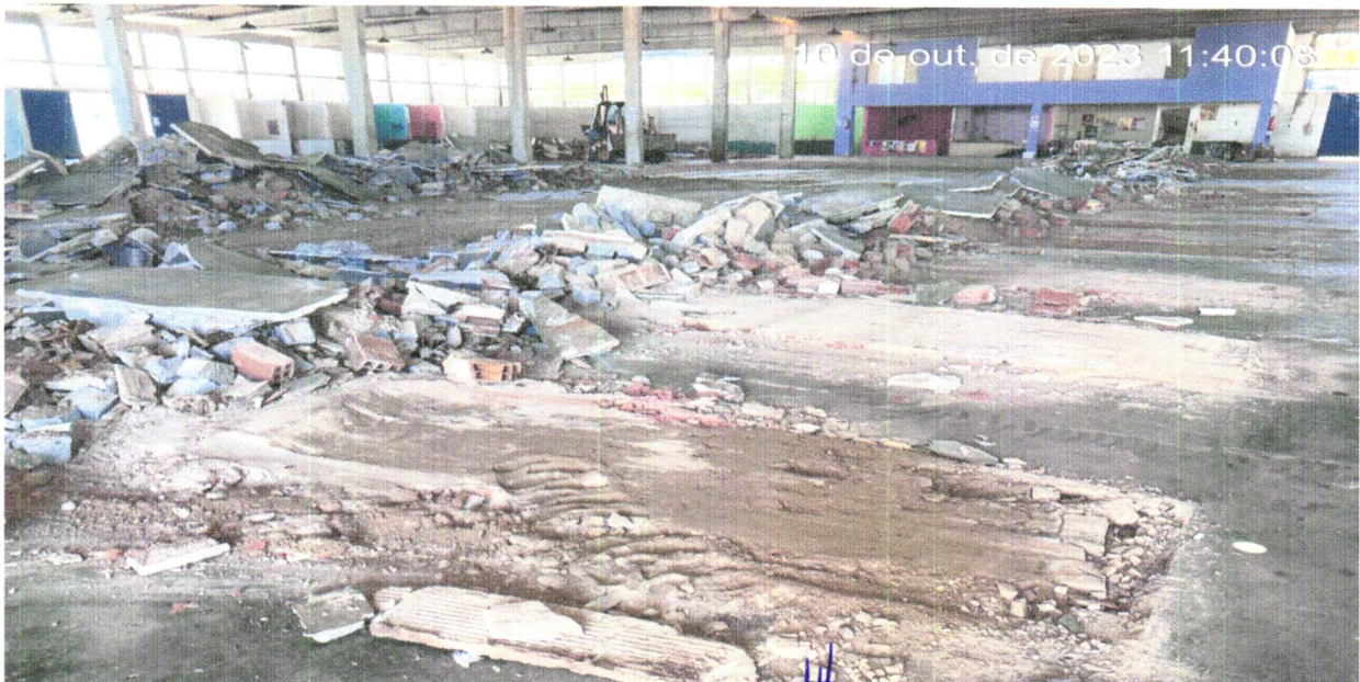
FOTO 24 - DEMOLIÇÃO MANUAL DE PISO CIMENTADO SOBRE LASTRO DE CONCRETO - REV 01
