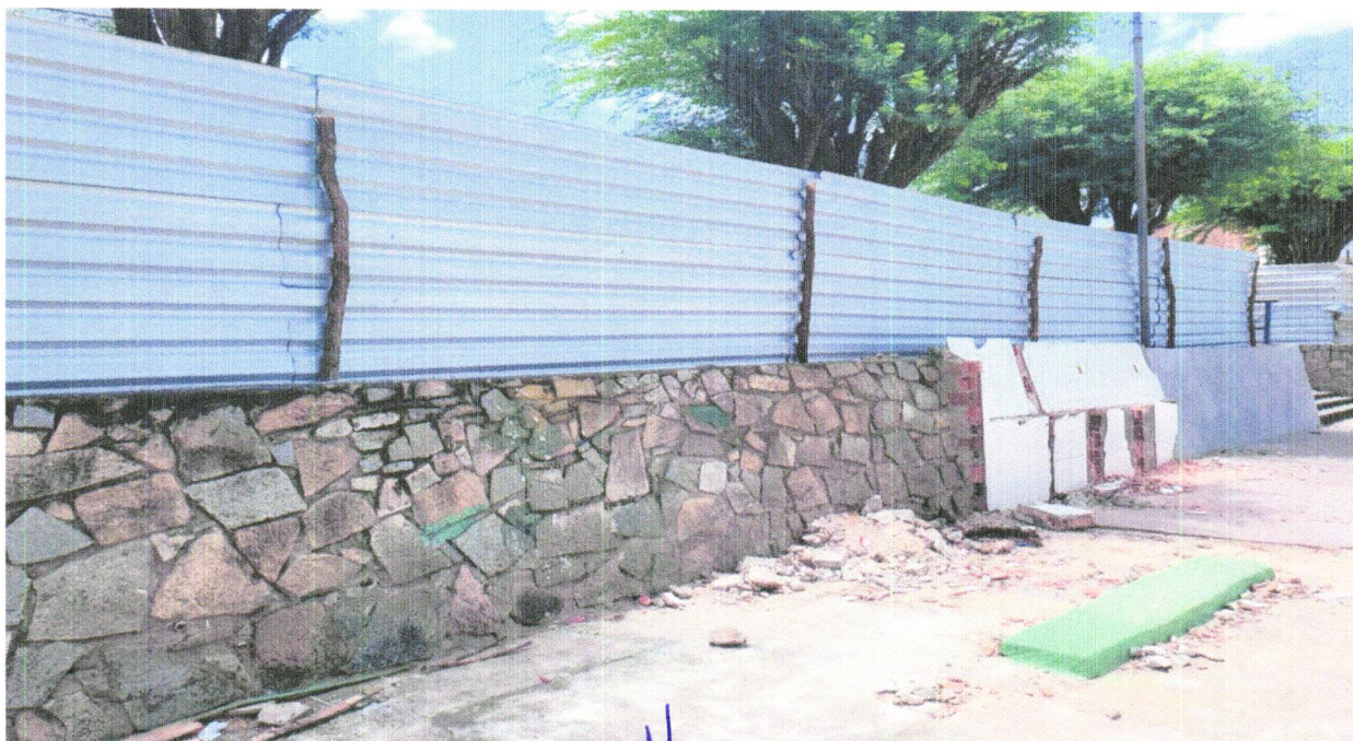
FOTO 12 - TAPUME COM TELHA METÁLICA. AF_05/2018
