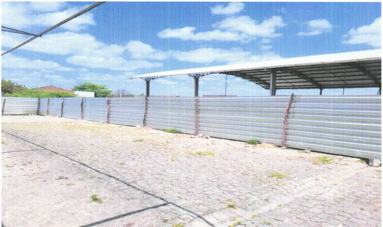
FOTO 06 - TAPUME COM TELHA METÁLICA. AF_05/2018
