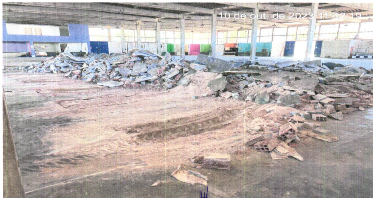
FOTO 26 - DEMOLIÇÃO MANUAL DE PISO CIMENTADO SOBRE LASTRO DE CONCRETO - REV 01
