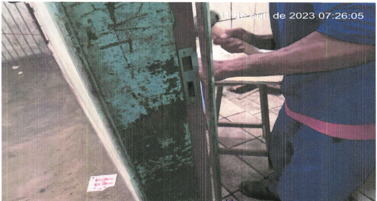
FOTO 32 - REMOÇÃO DE PORTAS, DE FORMA MANUAL, SEM REAPROVEITAMENTO.
