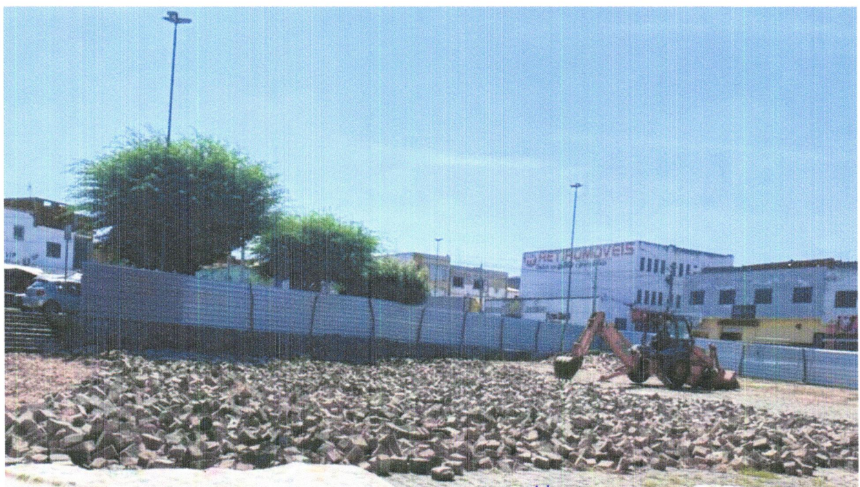
FOTO 20 - DEMOLIÇÃO DE PAVIMENTAÇÃO EM PARALELEPÍPEDO SEM REAPROVEITAMENTO
