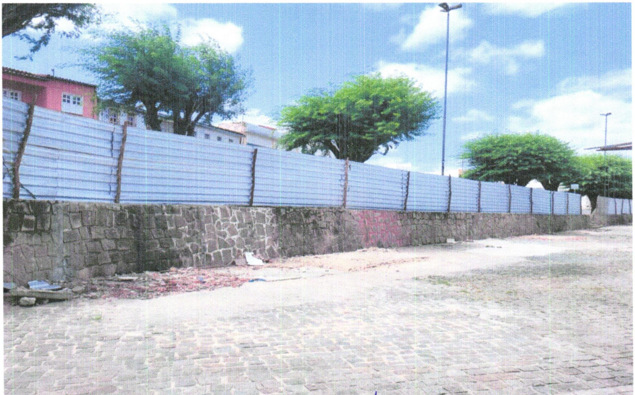
FOTO 04 - TAPUME COM TELHA METÁLICA. AF_05/2018
