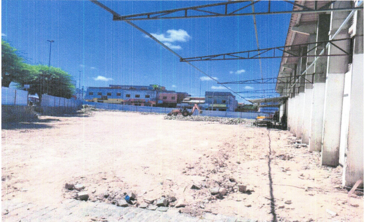
FOTO 20 - DEMOLIÇÃO DE PAVIMENTAÇÃO EM PARALELEPÍPEDO SEM REAPROVEITAMENTO
